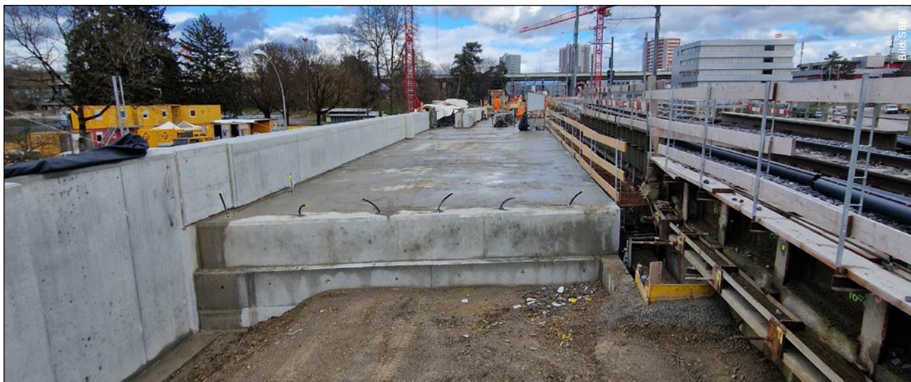
Die neue Decke der Unterführung Stöckacker auf der Nordseite ist fertig betoniert.
