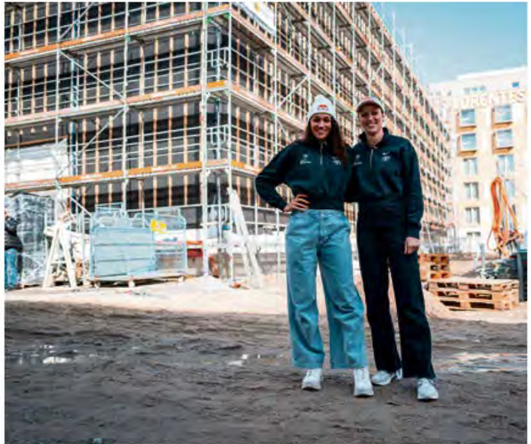
Zoé und Anouk Vergé-Depré vor dem Rohbau des Home of Beach. | Fotos: Luca Uloth
